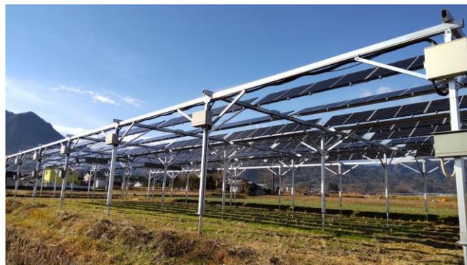
駐車場の屋根に太陽光発電を設置する「ソーラーカーポート」や、農地の上で太陽光発電を行う「営農型太陽光発電」（ソーラーシェアリング）が注目されています。
